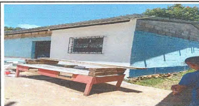
Foto 7: Repello de pared módulo 3.
