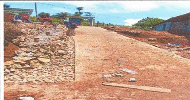
Foto 10: Construcción de muro perimetral módulo 8.
