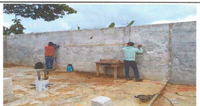
Foto 5: Reforzamiento de pared con cemento para evitar el filtro de agua módulo 3.
