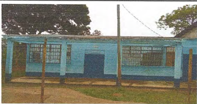
Foto 3: Instalación de estructura de techo módulo 2.
