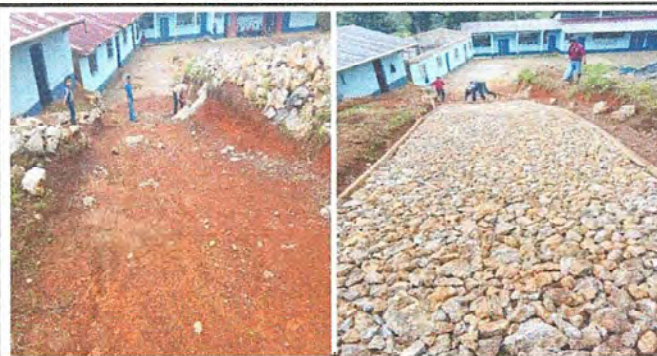
Foto 8: Encaminamiento hacia el establecimiento módulo 9.
