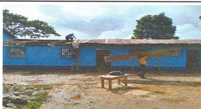
Foto 4: Desmantelación del techo de madera módulo 3.
