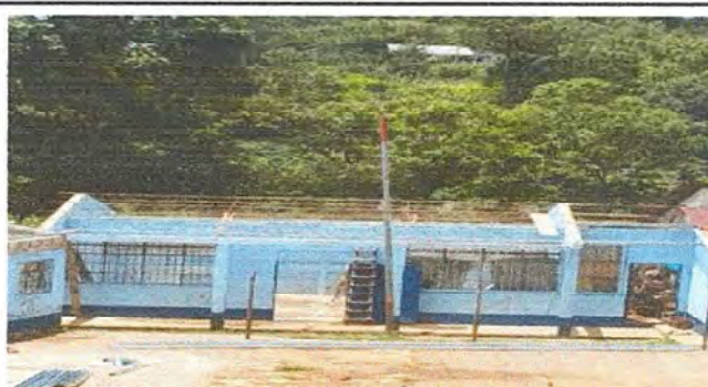
Foto 2: Desmantelación del techo módulo 2.
